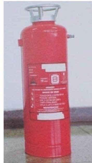
Na figura ao lado o extintor é de espuma mecânica com uma ampola externa contendo o propelente
